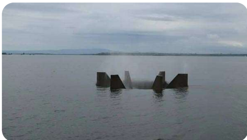
ภาพน้ำล้น spillway เขื่อนน้ำอูน จ.สกลนคร
