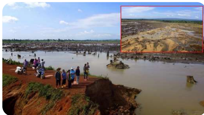
ภาพอ่างเก็บน้ำห้วยทรายขมิ้น จ.สกลนคร หลังประตุนายน้ำแล้งดินพัง
