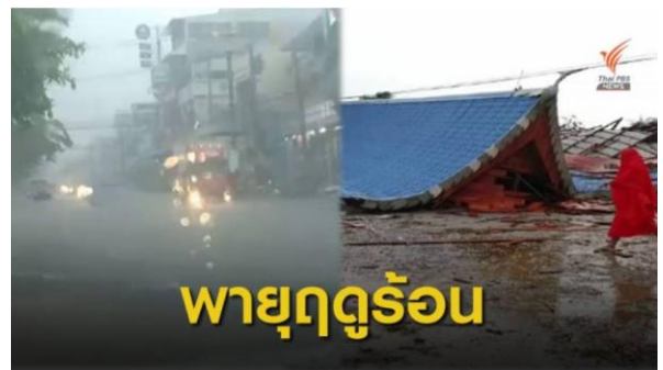
วันที่ 22 มี.ค. 64 ช่วงบ่ายเกิดพายุฝนและลูกเห็บตกในพื้นที่ อ.พบพระ จ.ตาก ทำให้ศาลาการเปรียญ วัดช่องแคบ พังถล่มทิ้งหลังต้นไม้ รวมถึงเสาไฟฟ้าหักโค่นปิดกั้นเส้นทางหลายจุด
