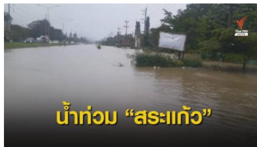
วันที่ 17 ต.ค. 63 เกิดน้ำป่าไหลหลากทะลักเข้าท่วมถนนสายหลัก สระแก้ว-จันทบุรี ระยะทางเกือบ 2 กิโลเมตร
