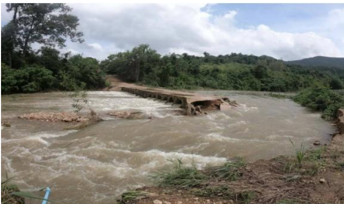
จังหวัดประจวบคีรีขันธ์ เกิดฝนตกหนักมีน้ำไหลหลากในพื้นที่ เมื่อ วันที่ 21 ก.ค. 61 พายุทางข้ามถูกน้ำป่ากัดเซาะเสียหาย
